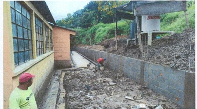
Foto2: TERMINACIÓN DE CAJA DE CORRIENTE DE AGUA PLUVIAL DEL AREA DE ARRIBA
