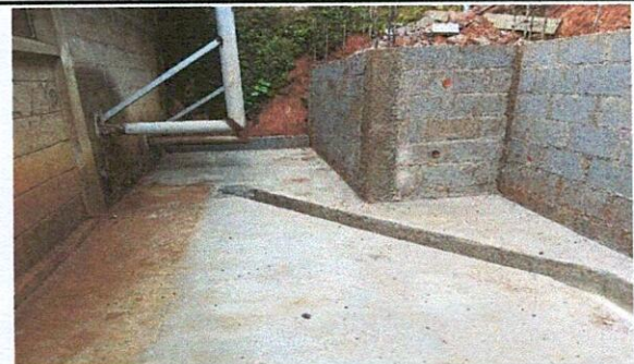
Foto 6: TERMINACIÓN DE MURO DE CONTENCIÓN CON DRENAJE FRANCES
