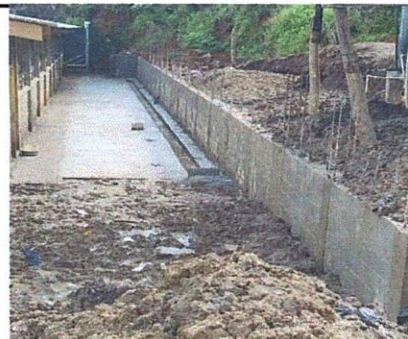
Foto 6: TERMINACIÓN DE LOSA DE PISO
