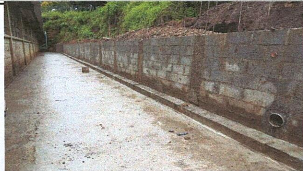
Foto1: TERMINACIÓN DE LOSA DE PISO
