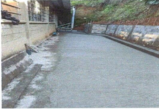
Foto1: TERMINACIÓN DE CUNETA PARA LA CORRIENTE DE AGUA PLUVIAL Y MURO DE CONTENCIÓN CON DRENAJE FRANCES
