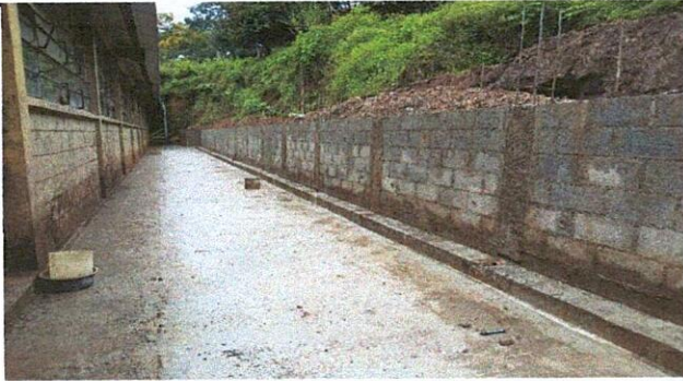
Foto 3: TERMINACIÓN DEL AREA DE MURO DE CONTENCIÓN CON DRENAJE FRANCES
