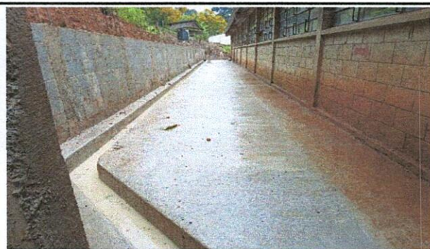
Foto 3: TERMINACIÓN DEL PISO Y LOSA
