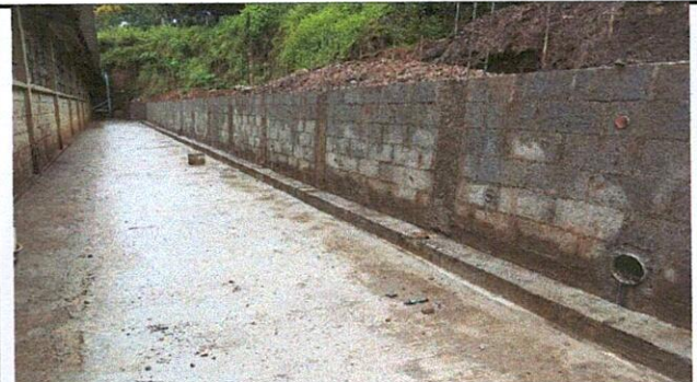
Foto 4: TERMINACIÓN DE CANAL DE AGUA PLUVIAL MURO DE CONTENCIÓN CON DRENAJE FRANCES
