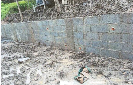
Foto1: TERMINACIÓN DE LA CAJA DE CORRIENTE DE AGUA PLUVIAL
