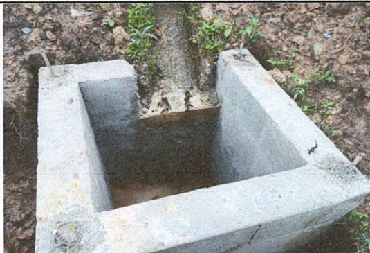
Foto 3: TERMINACIÓN DE LA CAJA DE CAPTACIÓN DE AGUA PLUVIAL PARTE DE ABAJO
