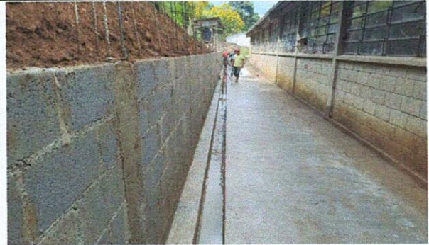
Foto2: TERMINACIÓN DE CUNETA PARA LA CORRIENTE DE AGUA PLUVIAL
